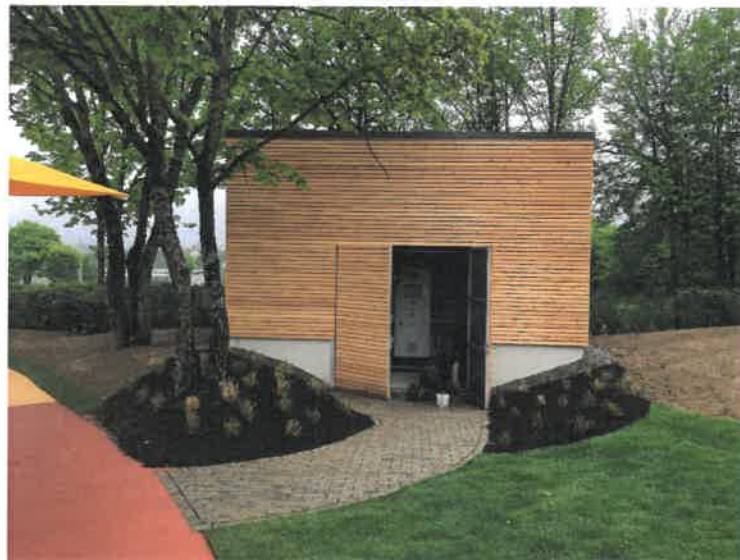
Bild eines separaten Technikgebäudes für ein abgelegenes Kinderbecken
